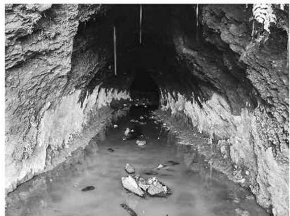
川辺地下壕の現状
