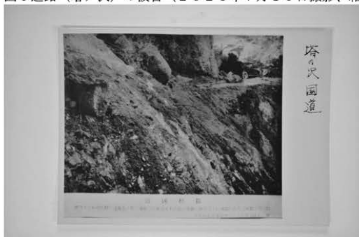
図6 道路（塔ノ沢）の被害（2023年7月10日撮影、箱根登山鉄道株式会社所蔵）
