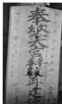
【写真④⑧】 大宮神社の明治39年の天井 「奉納大宮拝殿再建築〜 天下泰平日月晴明 大工棟梁 金谷 河邊 梶引 宮本」
