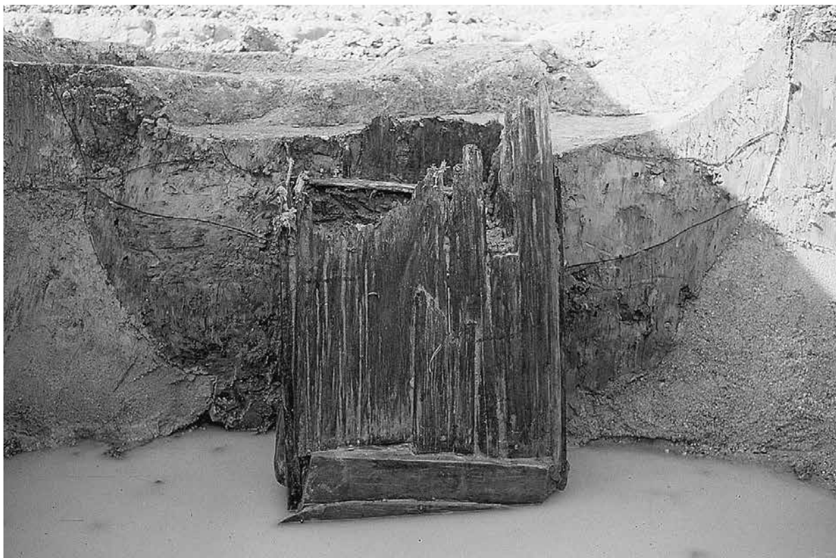
S E 301 断割状況（南より）
